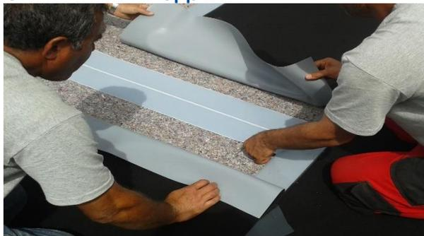
MasterSeal® 934 – это гидроизоляционная монтажная лента на основе FPO (эластичный полиолефин), с одной стороны покрытая клейким бутилкаучуком. Бутилкаучуковая поверхность оснащена защитной пленкой со швом для легкого снятия.
